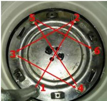
Placez le joint d'étanchéité neuf sur votre **chauffe-eau électrique**. *Attention au sens*, la partie la plus épaisse doit se trouver vers l'extérieur de votre appareil. Remontez l'élément chauffant ou le corps de chauffe en vissant progressivement sans trop serrer. Le serrage doit s'effectuer en *quinconce*.
