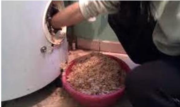
Pour **détartre** votre **chauffe-eau électrique**, retirez à la main le calcaire accumulé dans la cuve sans gratter. Passez ensuite un chiffon sur les parois pour finir de les nettoyer.
