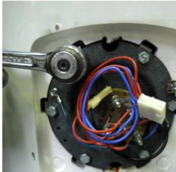
Retirez la platine en la maintenant dans son axe pour ne pas abîmer l'anode et la résistance qui sont fixées dessus.
